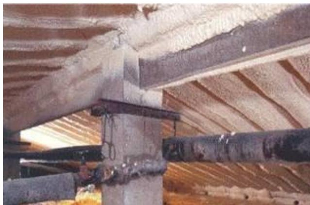
Благодаря технологическим свойствам пенополиуретан идеально подходит для утепления чердаков, внутренней стороны крыш (прекрасно ложится даже на потолочную поверхность), а также на вертикальных строительных элементах, таких как стены и фасады. Кроме того, пенополиуретан – идеальное средство изоляции пола, фундамента, подвала - не гниет и не разлагается.
