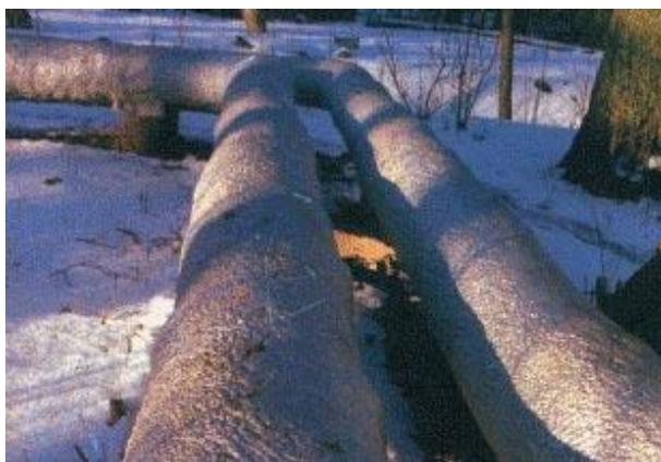
Пенополиуретан прекрасно подходит для теплоизоляции труб, теплотрасс. Нанесенная таким образом изоляция позволяет создать монолитное, полностью гидроизолирующее покрытие трубы. Дополнительной защиты не требуется – только покраска для защиты от прямых солнечных лучей.
